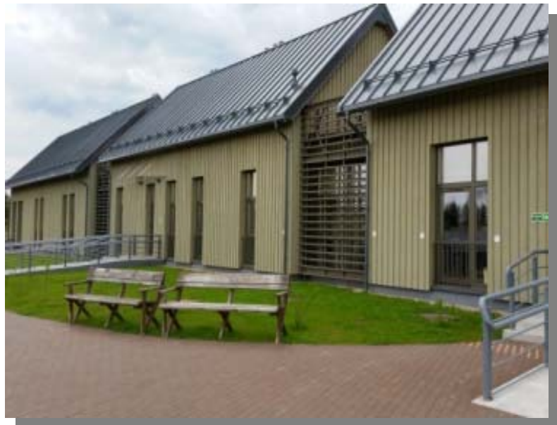
Det nybyggda ålderdomshemmet.
